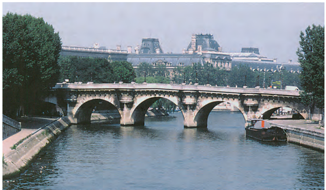
Εικόνα 5.8 Γέφυρα Μ. Αλεξάνδρου στο Σικουάνα
