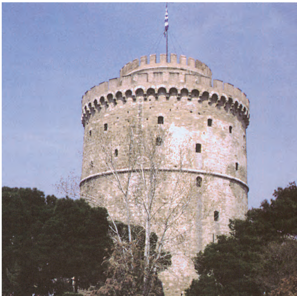
Εικόνα 3.32 Ο Λευκός Πύργος, σήμα κατατεθέν της Θεσσαλονίκης
