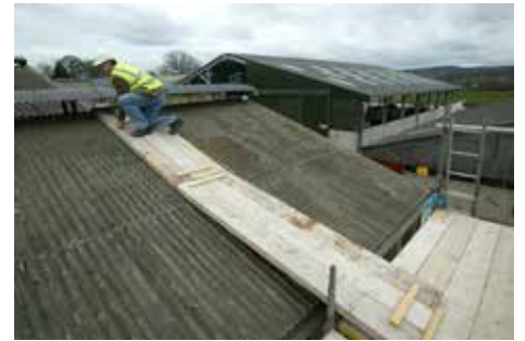
Σε εύθραυστες στέγες συστήνεται η χρήση σανίδων.
